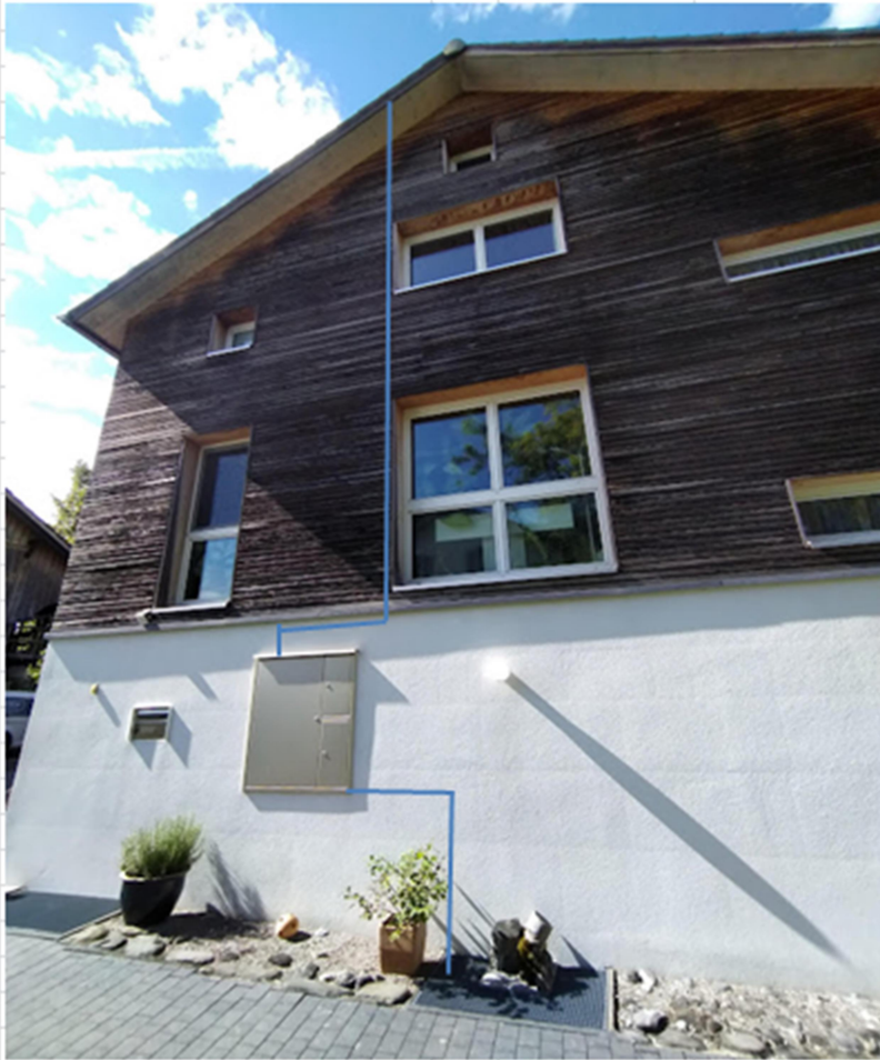
DC-Leitung (Leitung vom Modulfeld zum Wechselrichter) Durch Lichtsacht in den Heizungsraum
